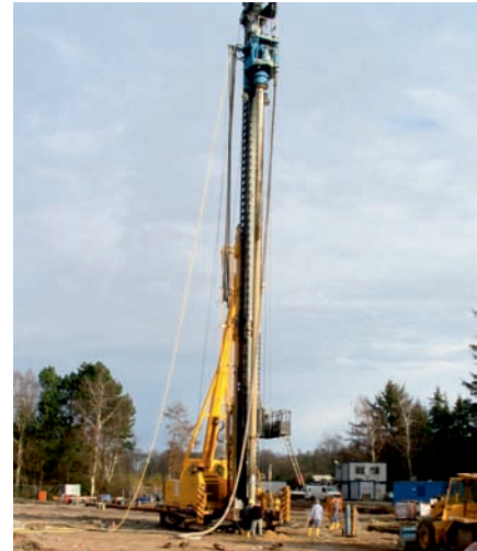
Mehr als 350 Pfähle wurden zur Gründung des Teilneubaus ins Erdreich eingebracht.
