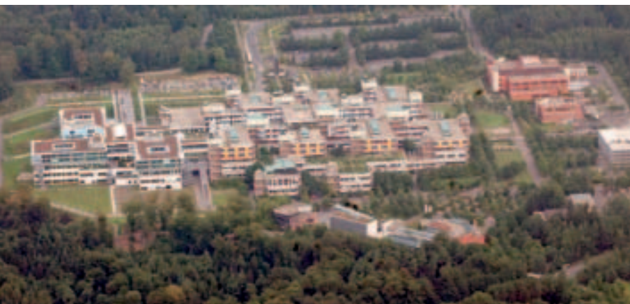
Vista aérea de la Universitätsklinikum Marburg, emplazamiento de Lahnberge
