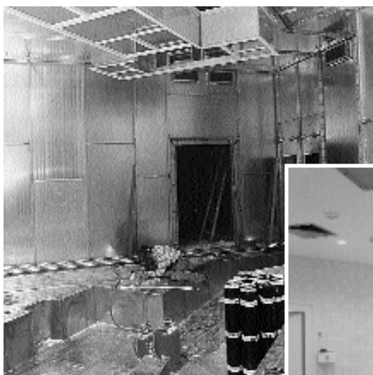
März 2000: Baubild offener MRT, Zentralklinik Bad Berka
