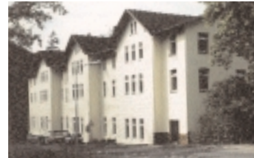
Krankenhaus Waltershausen-Friedrichroda GmbH
